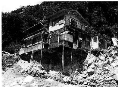
床下半分が流失した日向小屋
